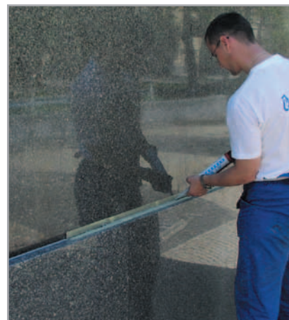
4.12 ábra – Homlokzati hézag lezárása MAPESIL LM-mel
