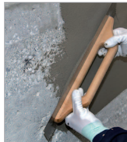
3.9 ábra – Fal kiegyenlítése PLANITOP FAST 330-cal
