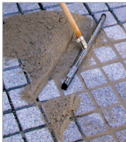
5.4 ábra – MAPEDRAIN 1K GROUT alkalmazása
