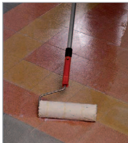
3.6 ábra – A tapadást elősegítő alapozó felvitele
