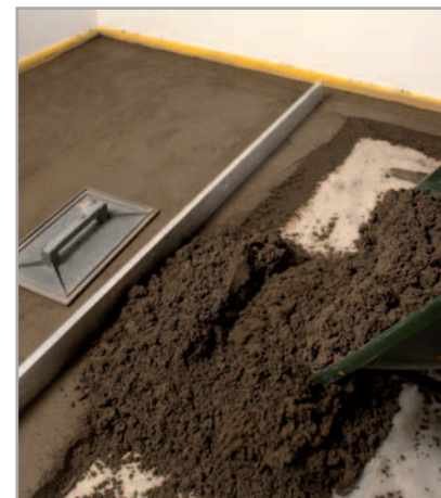
3.3 ábra – Esztrich készítése MAPECEM PRONTO-val
