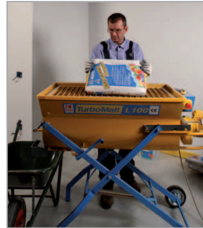
3.1 ábra – Esztrich bekeverése MAPECEM PRONTO-val
