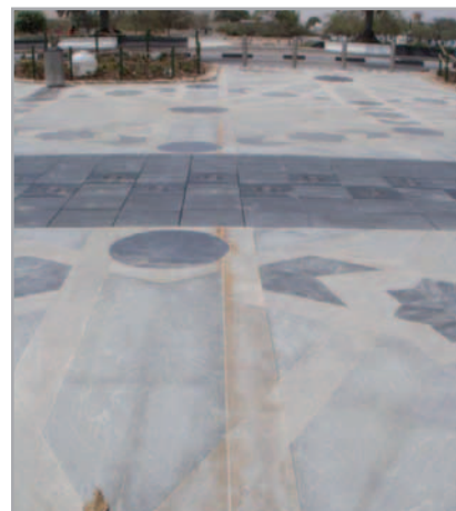
4.11 ábra – Ecetsavasan térhálósodó szilikonos tömítőanyag által okozott foltosodás természetes kőn
