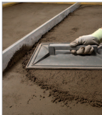
3.5 ábra – Az esztrich felszínének lesimítása kézi simítóval
