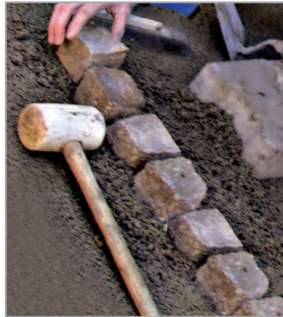
5.3 ábra – Porfír kockakövek lerakása MAPEDRAIN MORTAR-al
