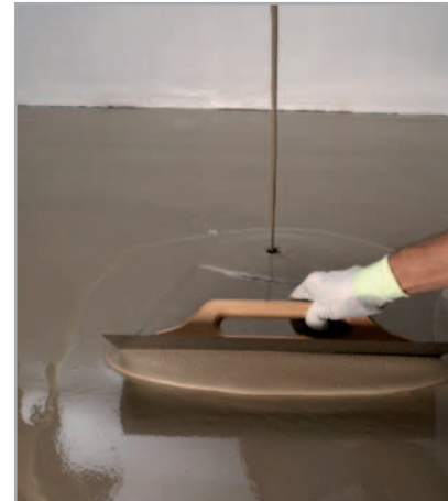
5.2 ábra – ULTRAPLAN-nal készült cementesztrich lesimítása
