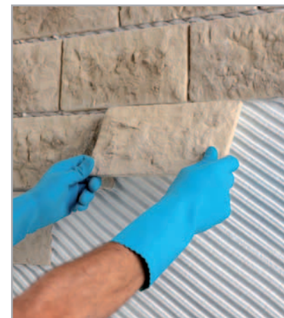
5.1 ábra – Kompozit díszítőelemek lerakása FIX & GROUT BRICK-ke
