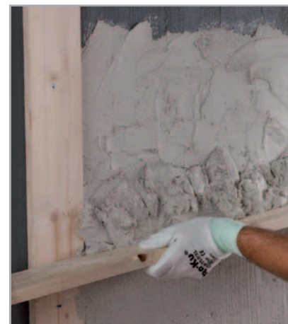
3.8 ábra – Betonfal kiegyenlítése NIVOPLAN+PLANICRETE-tel
