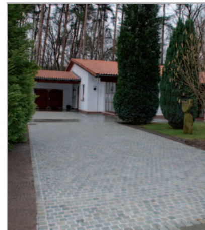
5.8 ábra – MAPEDRAIN MORTAR-al és MAPEDRAIN 1K GROUT-tal lerakott és fugázott porfír térköves burkolat
