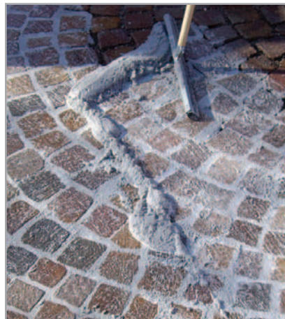
5.5 ábra – MAPEDRAIN 3K GROUT alkalmazása
