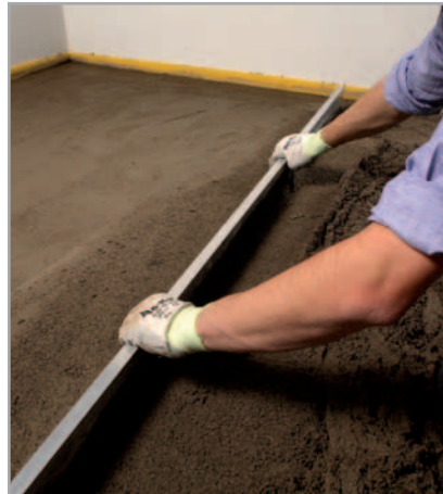
3.4 ábra – Az esztrich lesimítása simítóléccel
