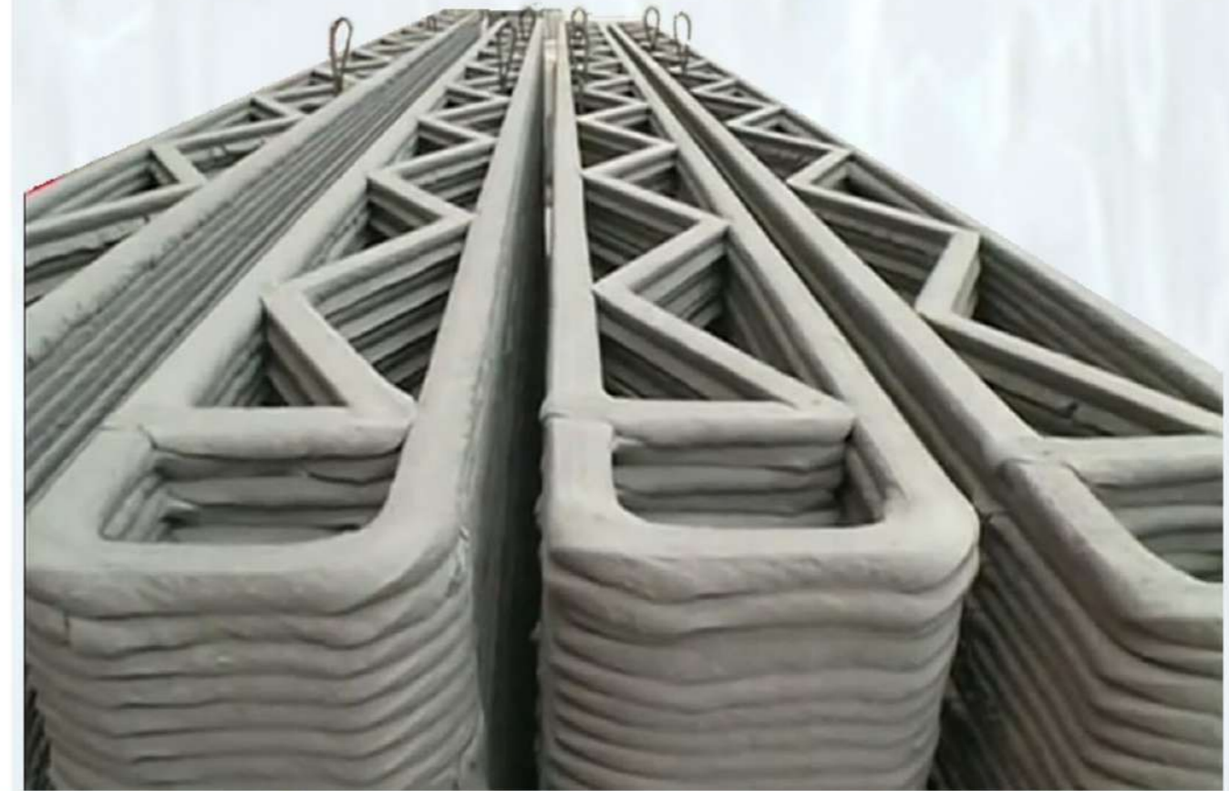
3 D nyomtatással készülő falszerkezet http://sobify.com/worlds-tallest-3d-printed-building-winsun-decoration-design-engineering/
