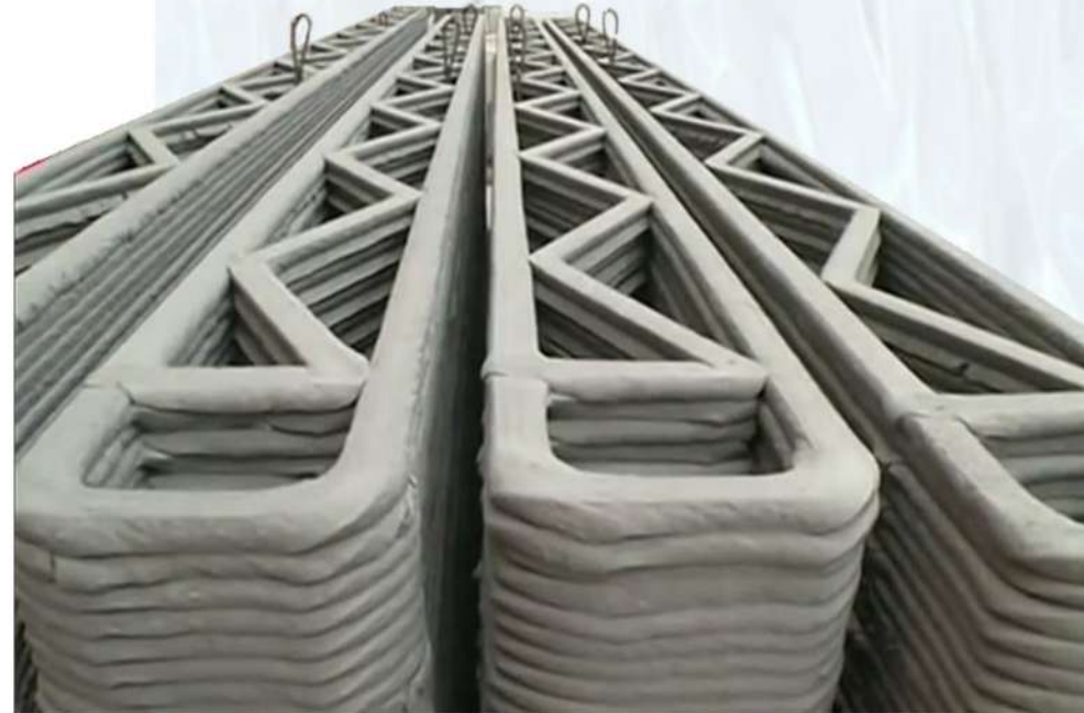
3 D nyomtatással készülő falszerkezet
