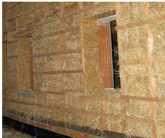
19. ábra: Analóg szerkezet megvalósulása: szalmabála hőszigetelés vázkerámia falazaton
